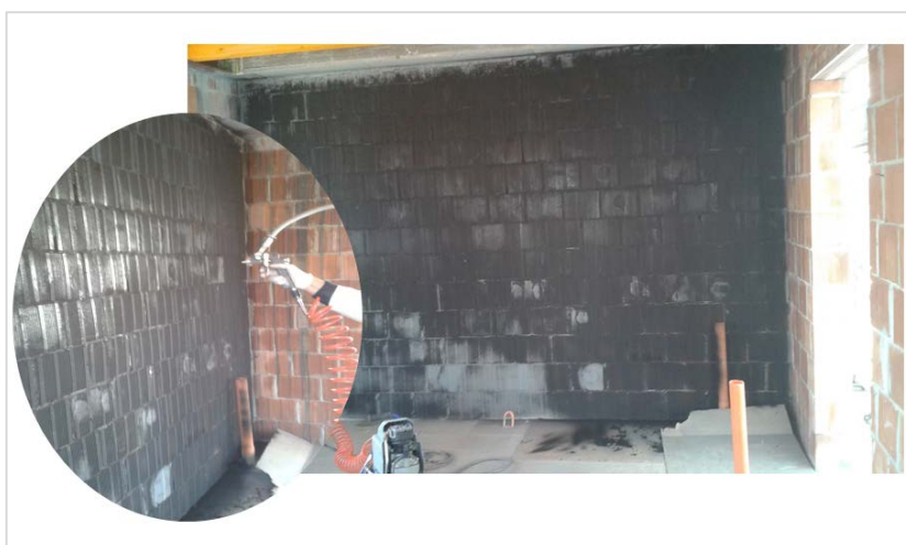
Fig. 2 - Applicazione di SUNSPACE mediante spruzzo su una parete interna di un edificio realizzato presso UniBs
