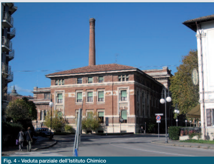
Fig. 4 - Veduta parziale dell'Istituto Chimico
