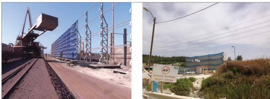
Fig. 6 - Dust Tex Net®: rete catalitica utilizzata per risolvere particolari problemi legati al contenimento delle polveri e delle particelle sottili in spazi aperti. Nell'immagine un sito presso Tel Aviv
