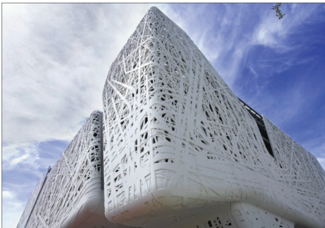
Fig. 2 - Expo-Milano. Utilizzo di cemento biodinamico. A contatto con la luce del sole, il principio attivo presente nel materiale consente di "catturare" alcuni inquinanti presenti nell'aria, trasformandoli in sali inerti e contribuendo così a liberare l'atmosfera dallo smog e dal particolato (www. Italcementigroup.com)
