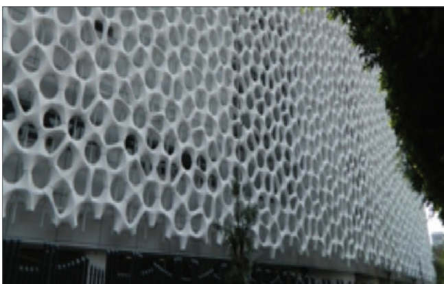
Fig. 3 - Torre delle Especialidades, Città del Messico. Materiale fotocatalitico in cui gli elementi ceramici della rete, costituiti di TiO_2 , sono in grado di assorbire batteri e smog atmosferico
