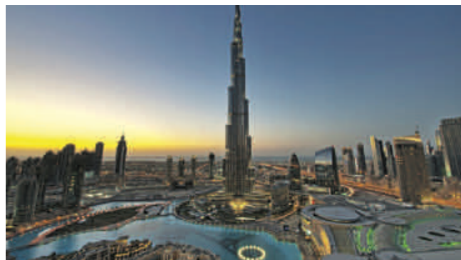
Fig. 1 - La Torre Burj Khalifa a Dubai, inaugurata nel 2010 (altezza 828 metri, 163 piani, 330.000 m 3 di calcestruzzo gettati in opera)
