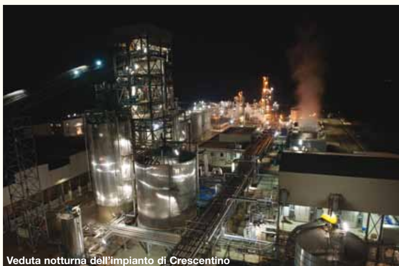
Veduta notturna dell'impianto di Crescentino
