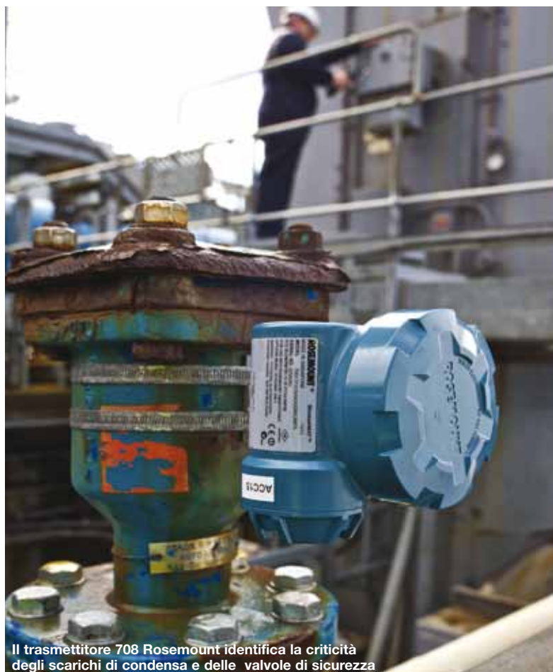
Il trasmettitore 708 Rosemount
